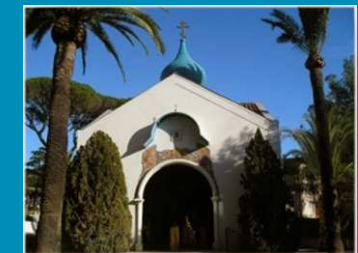
Eglise russe orthodoxe de Saint-Raphaël Archange, Saint-Raphaël, Var
