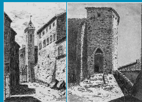
La porte d'entrée du village (XIIe s.) a été transformée en clocher.
